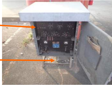
Transformer Rectifier Unit (PW-TRU)
